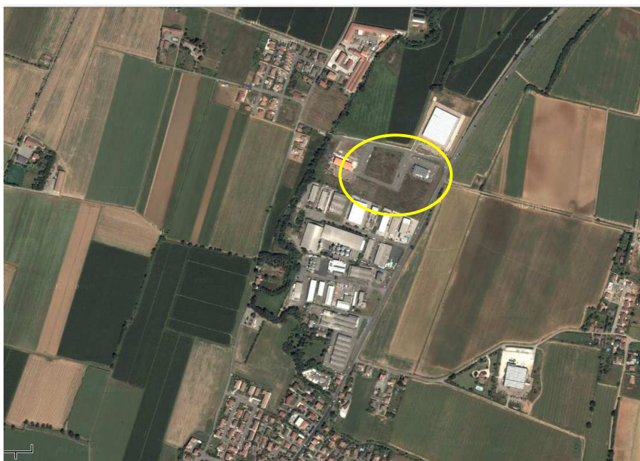
Niviano, ambito produttivo a nord la zona in corso di costruzione
