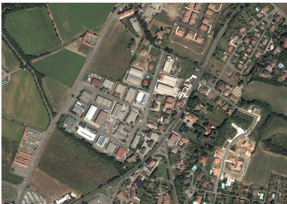
Rivergaro, zona produttiva.
